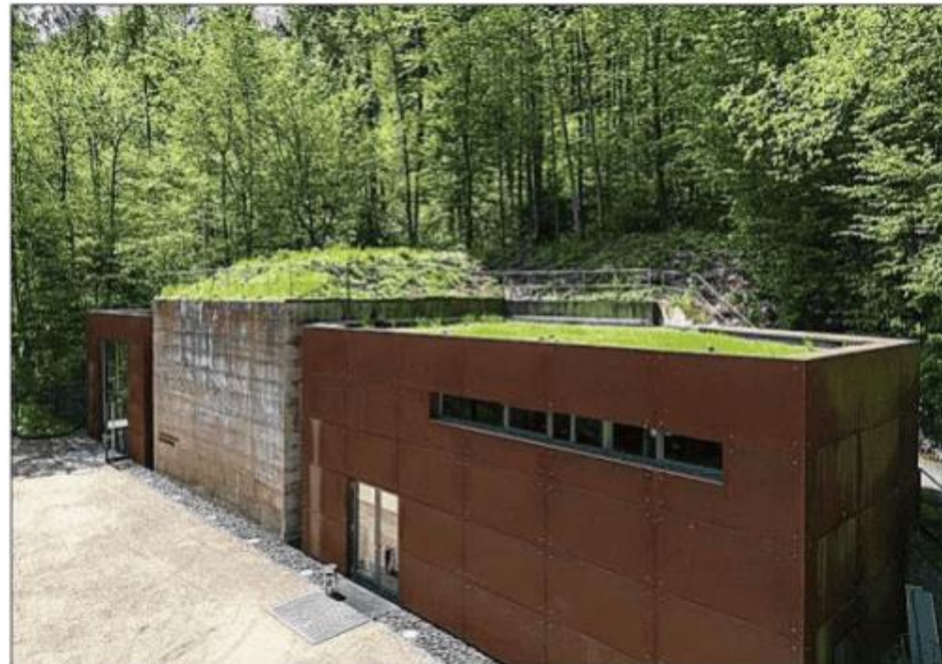
Aspecto exterior del búnker, que tenía capacidad para unas mil personas. GETTY
